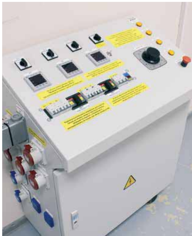
Фото 2. Стенд проверки автоматического ввода резерва
